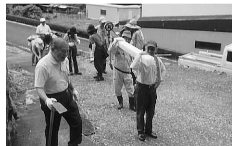
ヒノキ材で標柱を新設
